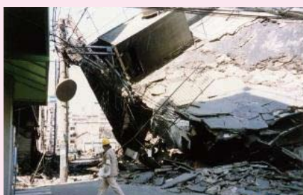
建築物が倒壊し道路を遮断すると緊急・応急活動に支障が出ます。
