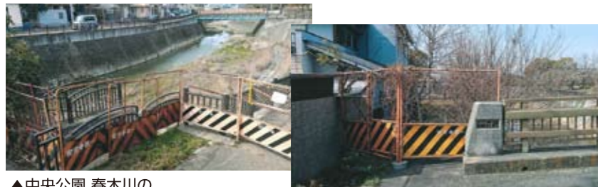
▲中央公園 春木川の親水空間侵入止めの状況
