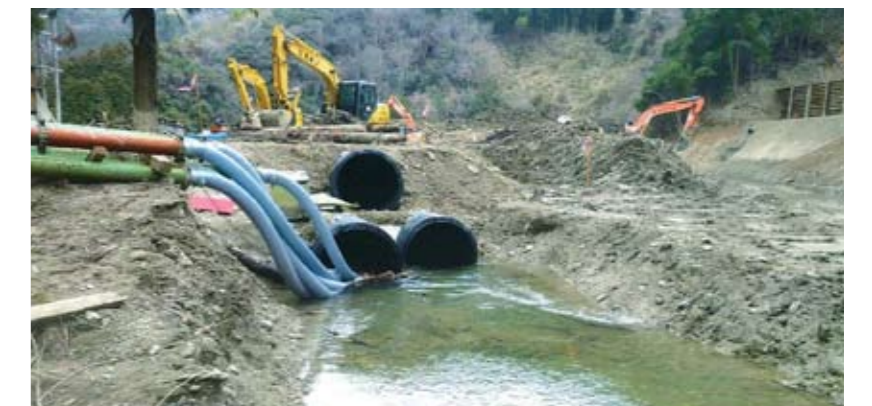
▲大沢町牛滝川の仮水路の状況
