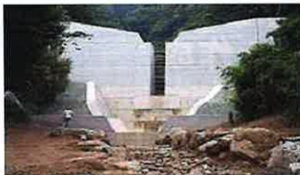
▲日下川砂防えん堤
