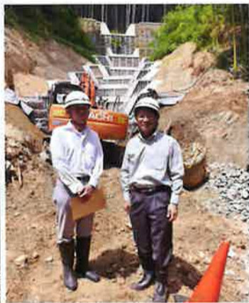
▲河南町の工事現場
