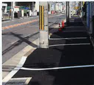
▲府道2号線の段差解消
