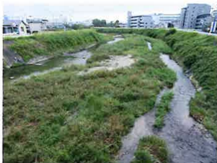
土砂撤去前の現況(巡礼橋下流)
