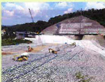
▲工事中の安威川ダム
