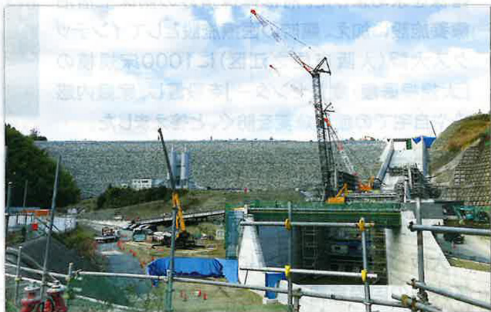
建設中の安威川ダム
